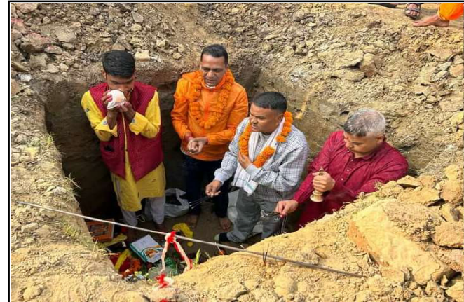
मंसिर १७ गते आईतवार सशस्त्र प्रहरी बल नेपाल ९ नं. गण जलसागरमा निर्माण हुने ४ कोठे अतिथि गृहको शिलान्यास ।
